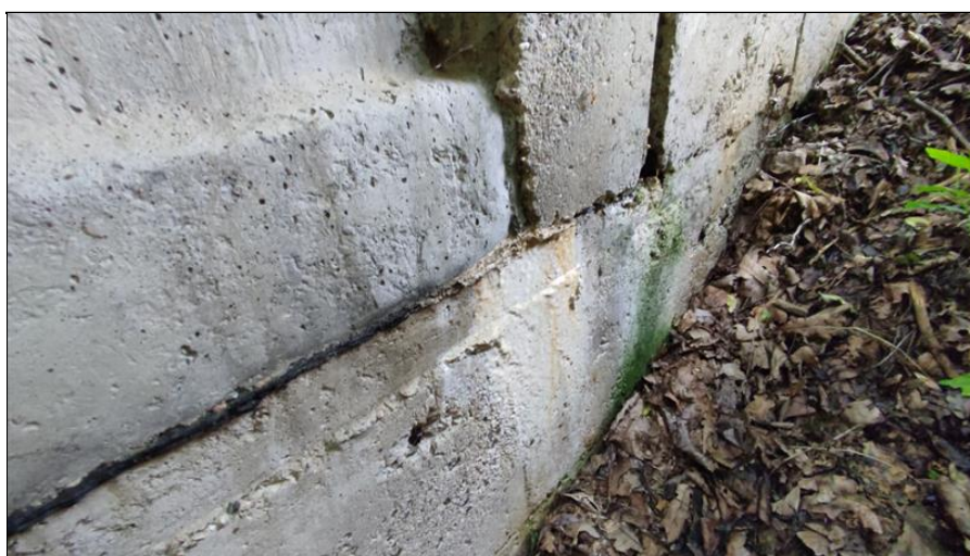
Detail vápenných výluhů z uložení NK
