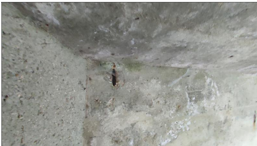
Nedostatečné krytí výztuže nosné konstrukce
