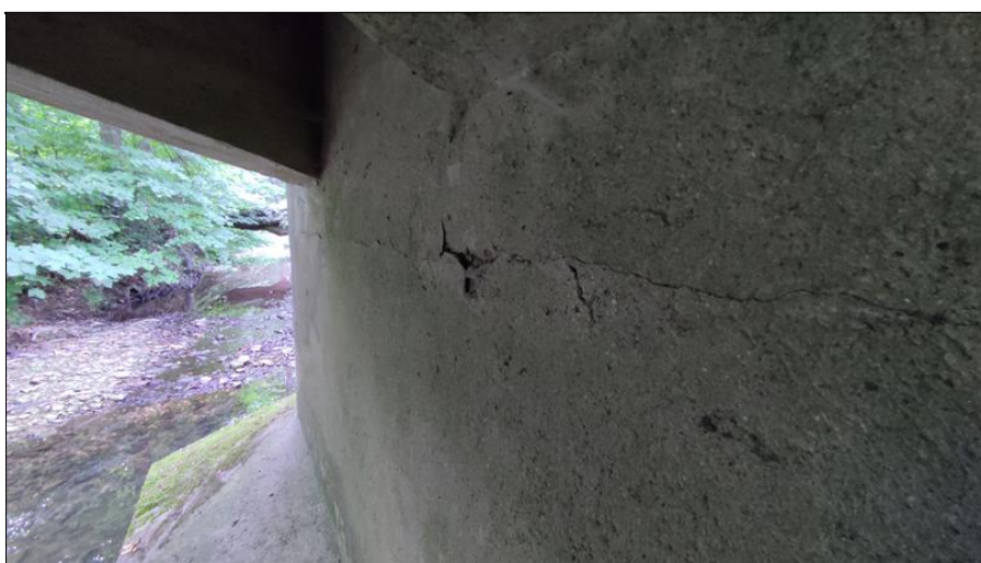
Podélná trhlinka na levé straně OP2
