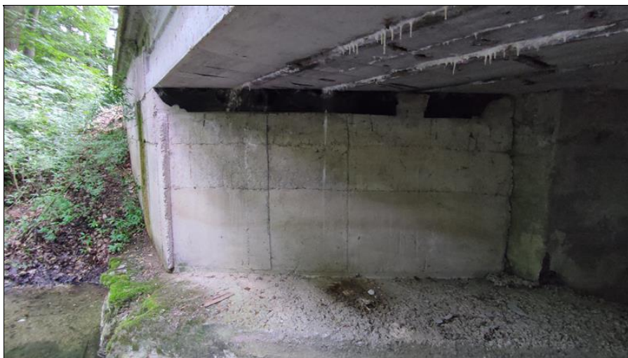
Pohled na rozšíření opěry OP1
