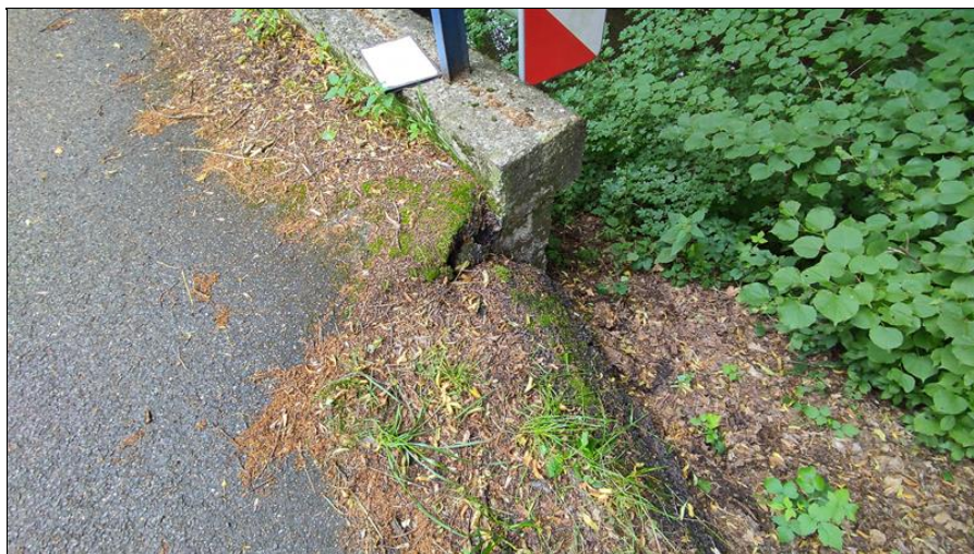
Detail poklesu vozovky za římsou na pravé straně u OP1
