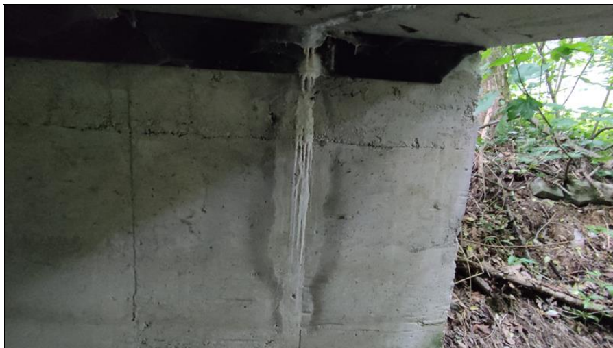
Detail vápenných výluhů na ze- spáry mezi nosníky na opěře OP2
