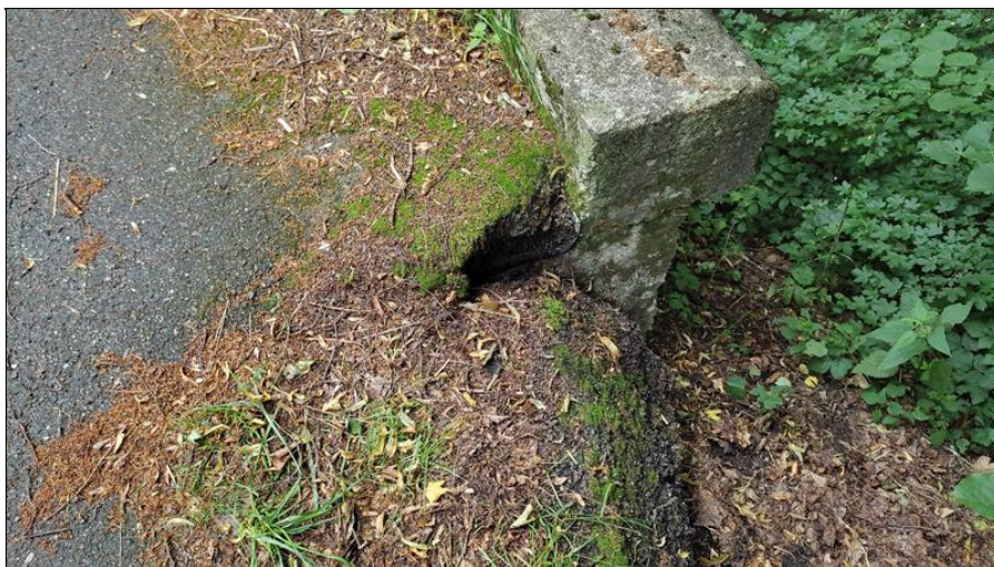
Pokles krajnice a vymílání materiálu před OP1 vpravo
