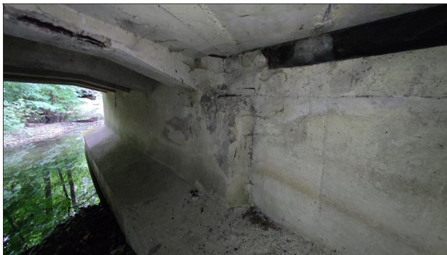
Detail přechodu opěry na její rozšíření
